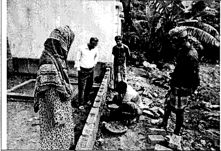
স্কিমের কাজ চলমান অবস্থা
